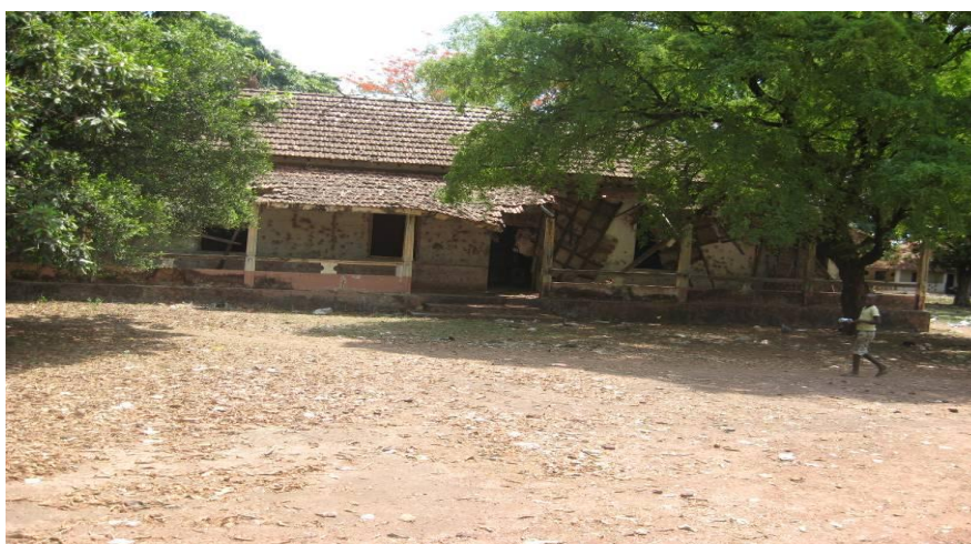
Residência do Administrador, Tite
